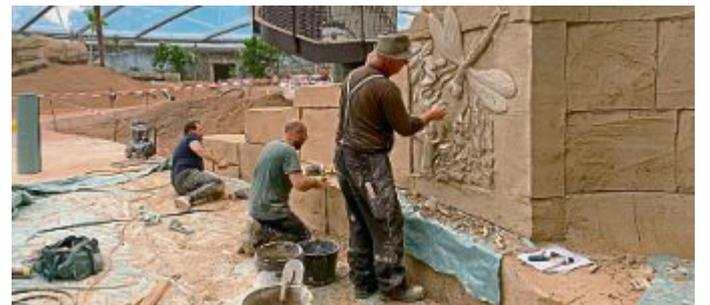
Für ein solches Modell wird zuerst eine Stahlverankerung mit Rundstahl geschweißt (l.). Darauf Glasfasergewebe gegeben und in mehreren Schichten Beton drauf gespritzt. Mit Spezialwerkzeug werden dann die Modelle geshaped, modelliert.
