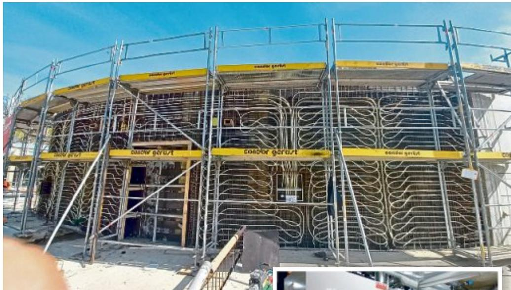
Es sind circa 14 Kilometer Rohrleitungen in den Wandflächen verbaut worden. Das kleine Bild zeigt die vier Wärmepumpen.
