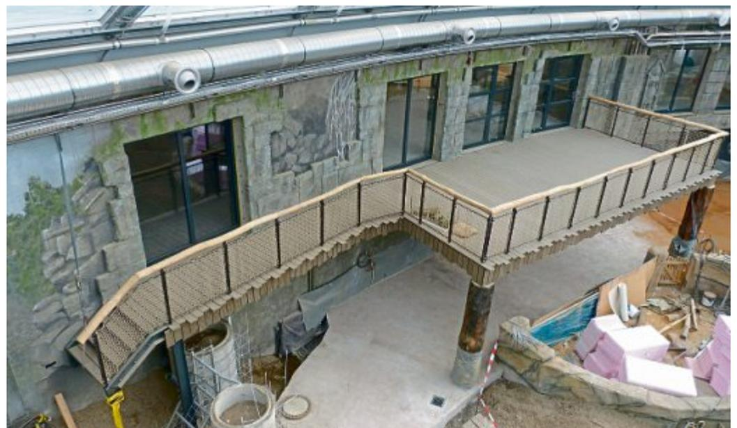
„Aufgrund der ovalen Hallenform haben wir hier keine gerade Wand, an der die Terrasse anschließt“, nennt Hans Hoehne eine Schwierigkeit bei den Metallbauarbeiten.
