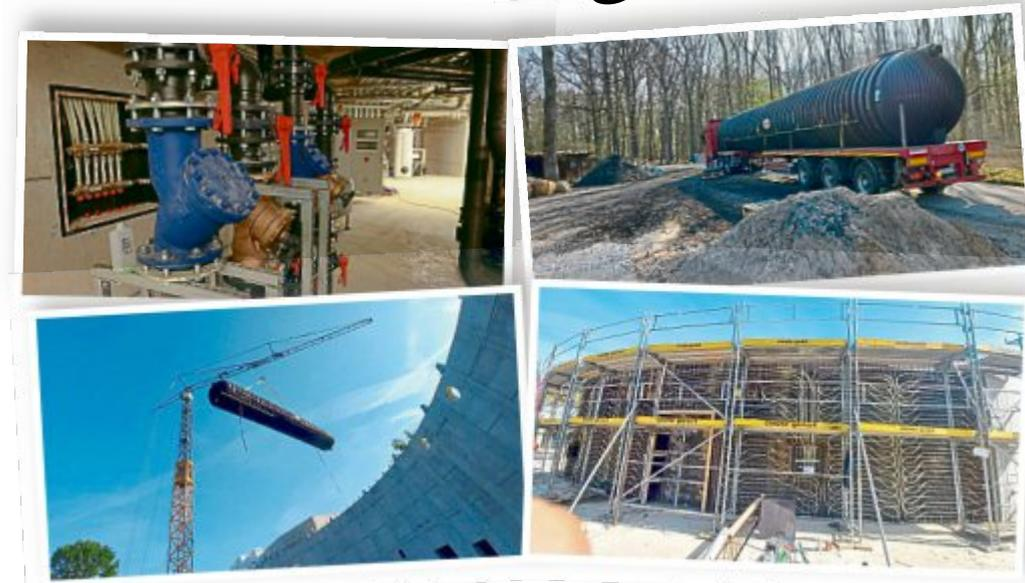
Beginn der vier Wärmekreisläufe (o.l.), der Tank (o.r. und u.l.) und 13 Kilometer Leitung in den Wänden (u.r.).
